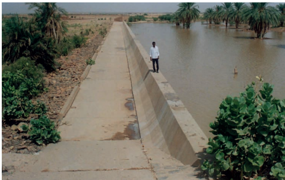
Photo 12: Barrage d'Amder-Atar (Adrar). Déversoir-poids en béton cyclopéen suivi d'un bassin à ressaut, également revêtu en béton.
