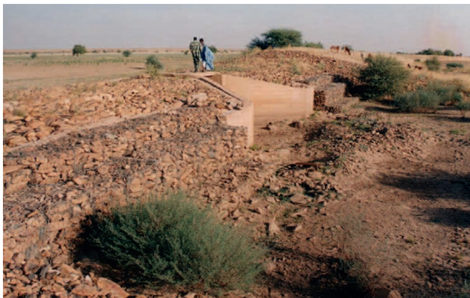
Photo 9: Barrage de Zemal (Brakna). Vue de la zone déversante aménagée dans le remblai, protégée par des enrochements posés sur un géotextile et prolongée par un dissipateur d'énergie en gradins de gabions.
