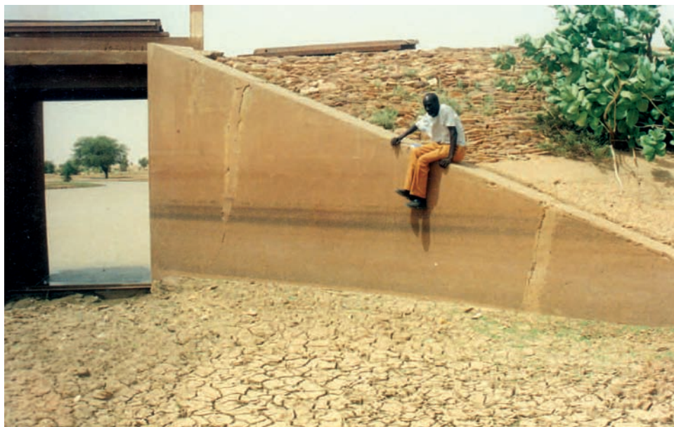
Photo 5: Protection du talus amont du barrage de Magta-Lajar par des plaques de schistes placées en boutisses.
