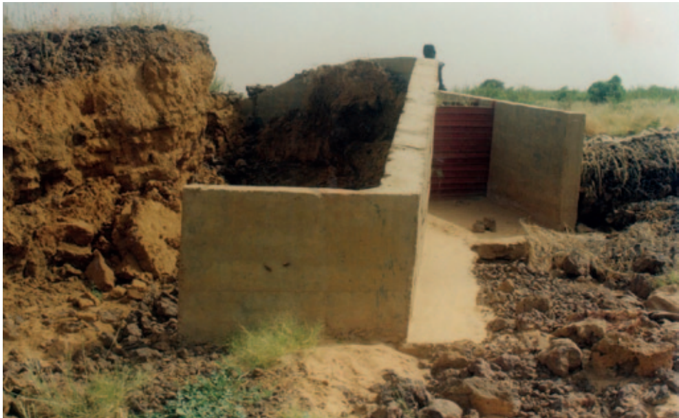
الصورة 10: انهيار ردمية بعد تعرضها لظاهرة التآكل الداخلي على مستوى التقاء أحد اكتاف حائط مفرغ الفيضان مع الردمية (سد وادي عباري بولاية براكنة).
