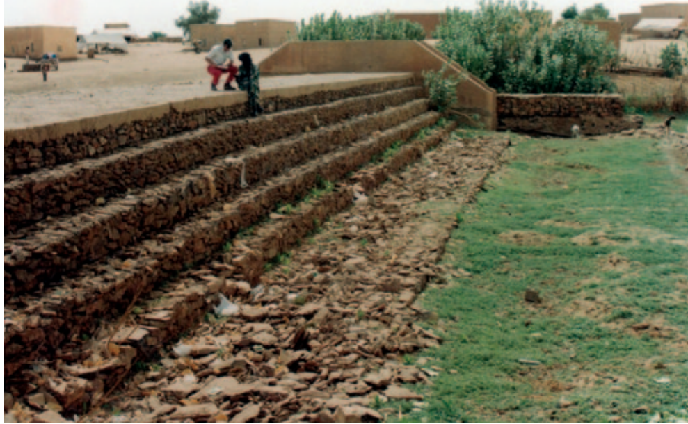
الصورة 13: سد سانقرافا (براكنة). مشهد لمصب ذي عتبة سمبكة من الخرسانة، موصول بمبدي طاقة من مدرجات متراسية وحوض تبديد بسيط من الصخور. أثبت هذا التصميم كفاءته فبالرغم من قدم المنشأة لم تظهر بها أي أضرار بالغة.
