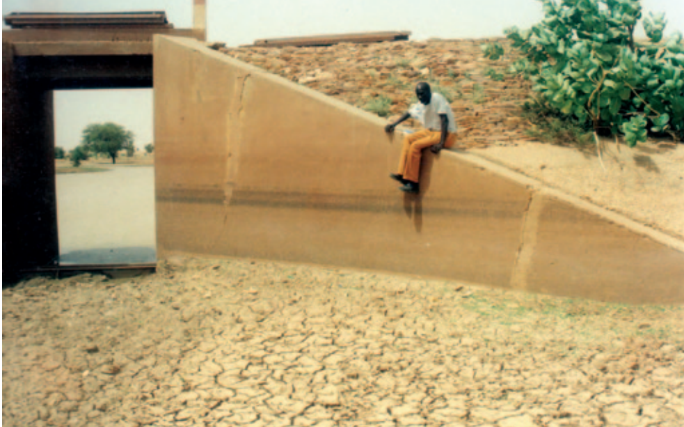
الصورة 5: حماية الجانب العلوي لسد "مقطع لجرار" بواسطة ألواح من الشبيست موضوعة على رأس الجانب العلوي للسد.
