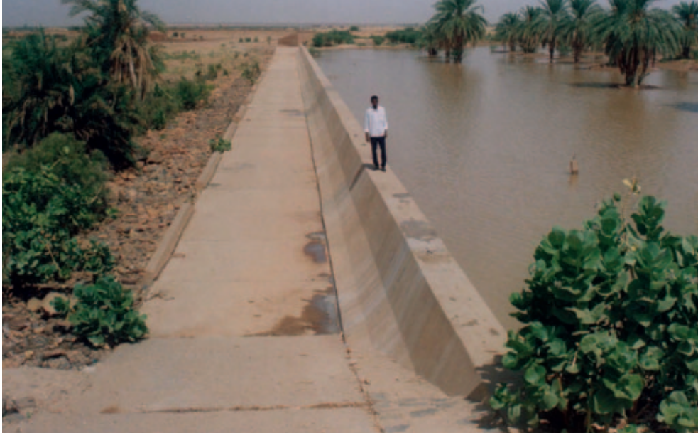
الصورة 12: سد امدير أطار (أدرار). مصب ثقلي من الخرسانة الصقلوية موصول بحوض إسقاط، مغطى أيضاً بالخرسانة.
