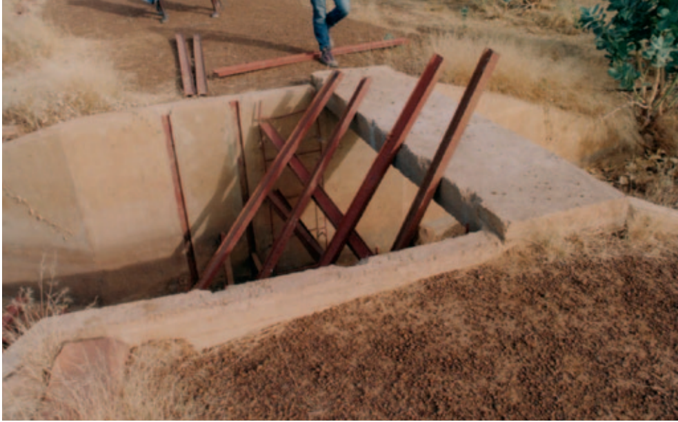
الصورة 15: منشأة تفرغ تقليدية من الخرسانة، سد بوخليخل- الحوض الغربي.
