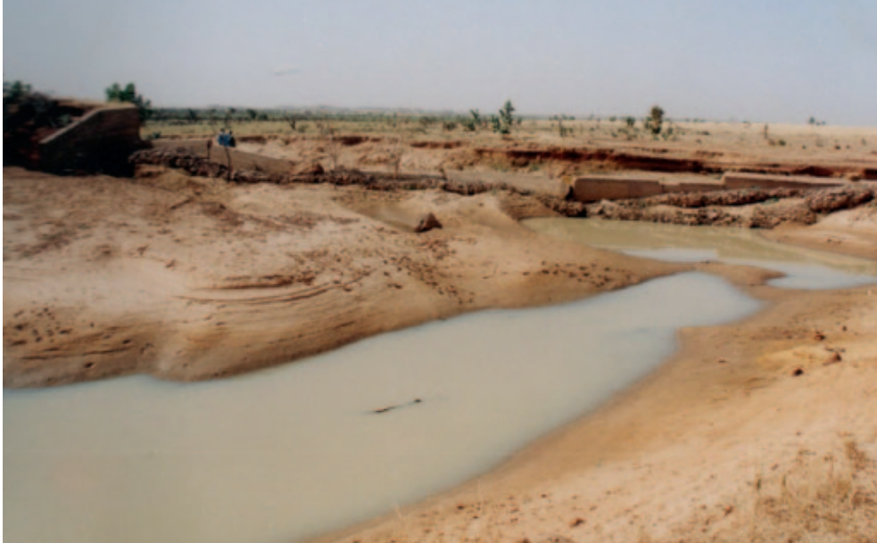
الصورة 7: انهيار مفرغ فيضان جانبي بسبب ظاهرة التعرية الارتدادية (سد باميرا، الحوض الغربي)
