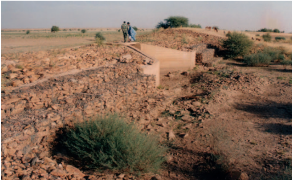
الصورة 9 سد زمال (براكنة). صورة لمنطقة التفريغ المهيأة الواقعة في الردمية والحماية بطبقة من الحجارة موضوعة على نسيج موه وممتدة عبر مبدد للطاقة مكون من مدرجات متراسية.
