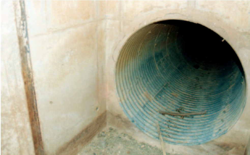
الصورة 16: الجزء الأعلى من مصرف خزان خليوا (براكنة). منطقة الاتصال بين فوهة ARMCO والمر بسكر.
