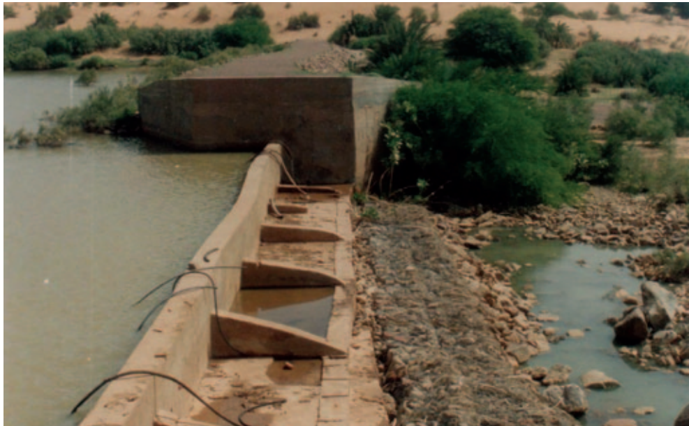
الصورة 3: سد تيارت (أدرار)، شفط مبسط للمياه بواسطة شافطات (أنابيب توضع ببساطة فوق مفرغ الفيضان).
