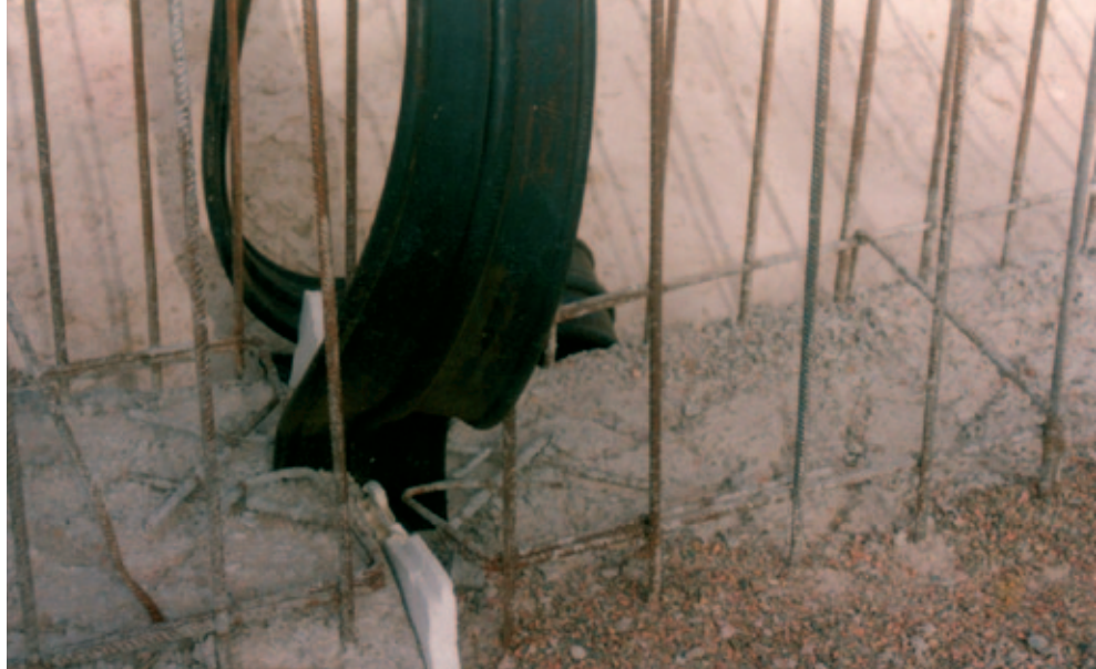
الصورة 8: فاصل خرسانة. يتم الفصل بين القطعتين بواسطة لوح من البوليسيتيرين. ويتم منع التسريب بواسطة وضع فواصل من نوع waterstop يتم صب كل فاصل في القطعتين المتجاورتين.
